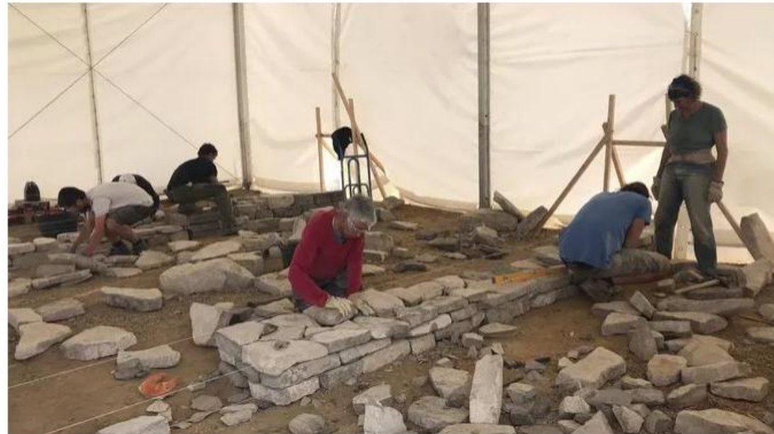
Els alumnes aixecant els murs de pedra seca (Catalunya Ràdio/Roger Santaló)
